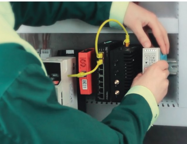
Instalación del switch industrial TI-PG80 de TRENDnet en el soporte de montaje DIN-Rail.
