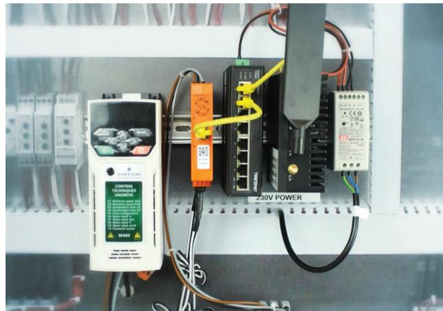
Switch industrial TI-PG80 da TRENDnet instalado em um DIN-rail como parte do sistema de monitoramento inteligente SAM4.
