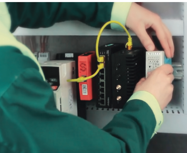
Installation du switch industriel TI-PG80 de TRENDnet sur la fixation rail DIN.
